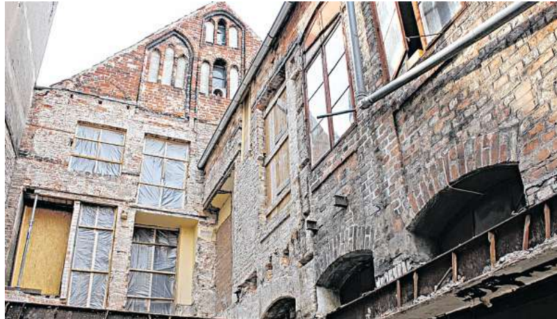
Der alte Rückgiebel (l.), vermutlich aus der Zeit um 1268, ist ziemlich marode, die Bögen im jüngeren Seitenflügel (r.) sind noch erhalten. FOTO: S. RISCH
