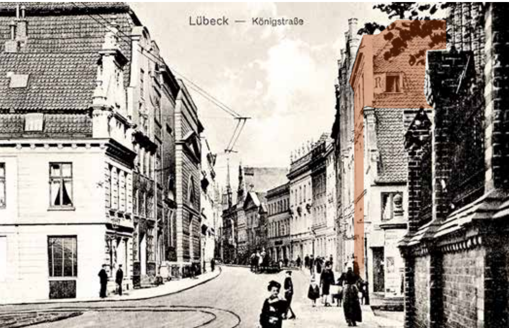
Königstraße, links Pfaffenstr. mit Bahnlinie, rechts Mauer der Katharinenkirche (Glockengießerstr.) 1914
