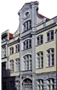
Mengstraße 40, Fassade heute
