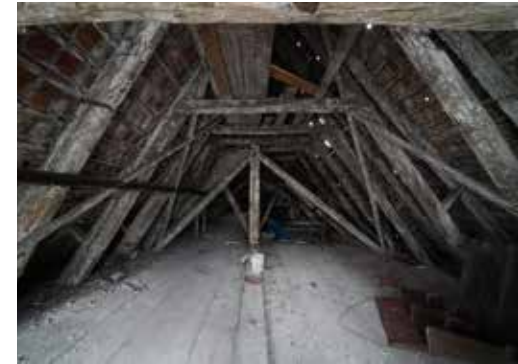
Ältestes komplett erhaltenes Dachwerk der Stadt Lübeck
