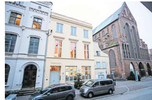
Aus der ehemaligen Hanseaten-Diele in der Königstraße ist das Haus Eden geworden. Die Sanierung steht kurz vor dem Abschluss.
