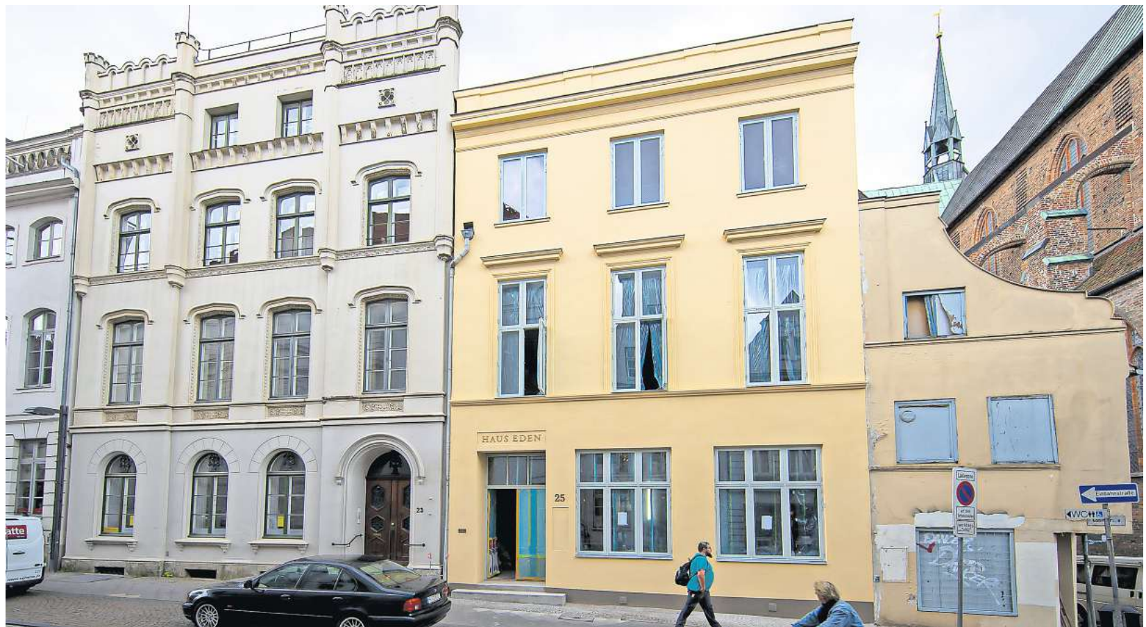
Die neue Fassade des „Haus Eden“ in der Königstraße 25 mit dem wieder an die ursprüngliche Stelle verlegten Eingang. Der kleine Anbau rechts an der Ecke zur Glockengießerstraße hat einen anderen Eigentümer und wird nicht saniert.
